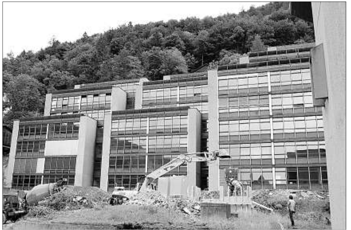
Erste Vorbereitungsarbeiten: Bauarbeiter bereiten den Platz für einen Baukran vor, mit dem das gesamte sanierungsbedürftige Kanti-Areal erreicht werden kann. (Foto Julian Reich)
