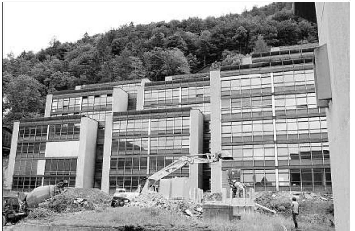
Erste Vorbereitungsarbeiten: Bauarbeiter bereiten den Platz für einen Baukran vor, mit dem das gesamte sanierungsbedürftige Kanti-Areal erreicht werden kann. (Foto Julian Reich)
